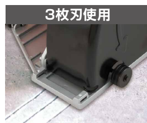
切断後、クサビを打ち込み割る。
